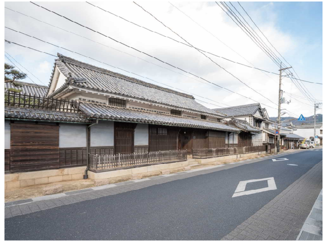
【写真2】街道沿いに漆喰塗込の重厚な町家が旧本陣や旧脇本陣とともに残る
